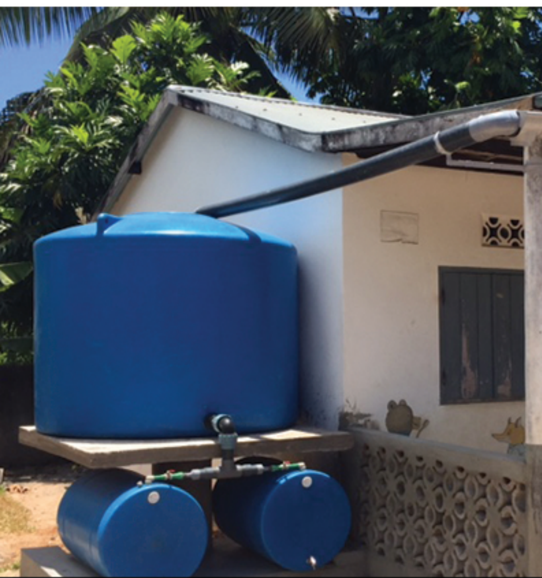
Ecole préscolaire de Vohilava : installation de 2 cuves d'eau potable alimentées par une citerne de récupération des eaux de pluie
