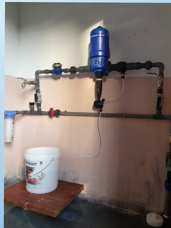
Le système de chloration du 1 er réseau avec le GRET
