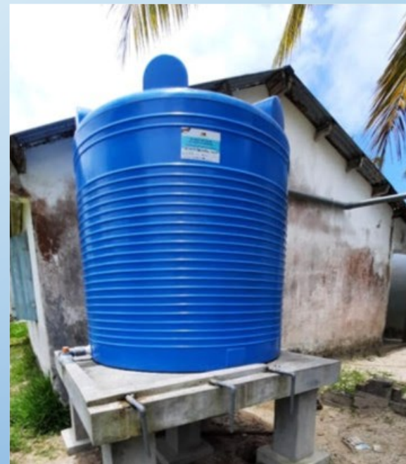
Cuve de 2500 L de récupération d'eau de pluie
